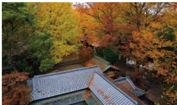
参集殿上空から
